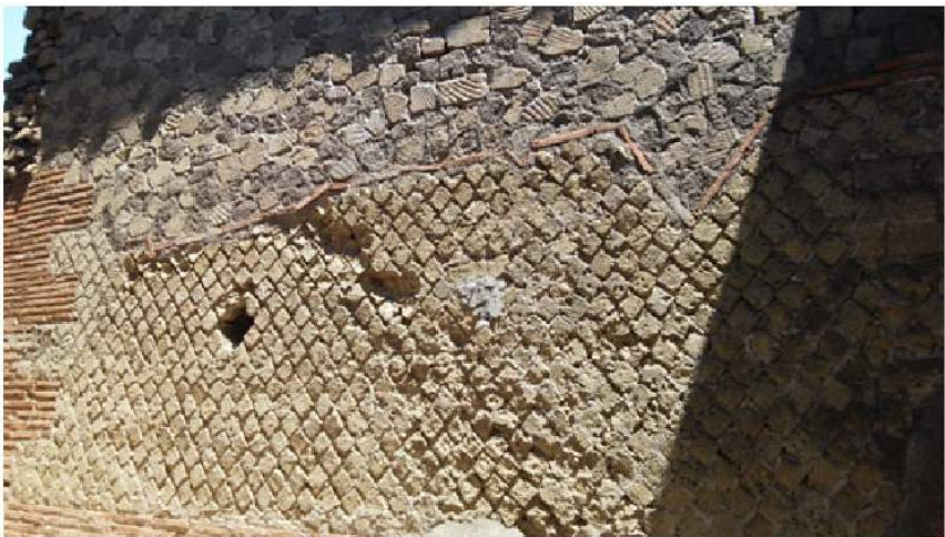
Riparazione di un muro con inserzioni di laterizio manubriatum terremoto 62 d. C Opus incertum sovrapposto all'opus reticulatum. Villa Arianna antica Stabiae
