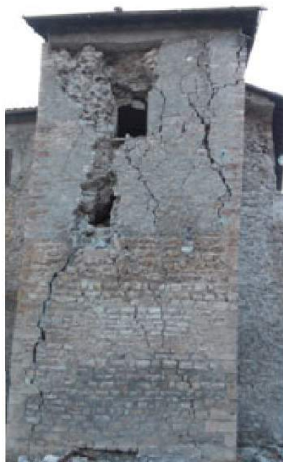
Cordolo in c.a. in sommità su muratura in pietrame
