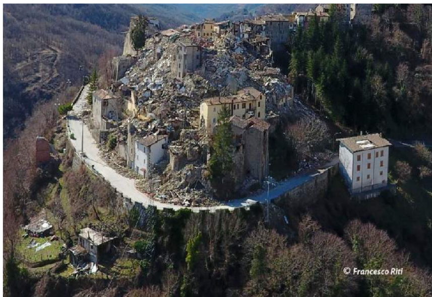
Veduta aerea di Arquata del Tronto dopo il sisma.
